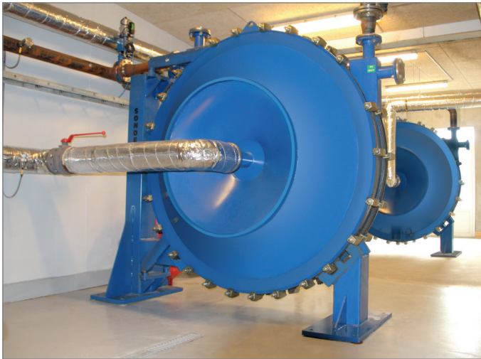
Danimarka'daki Linko Gaz tesisindeki Sondex spiral ısı deęiřtirici
